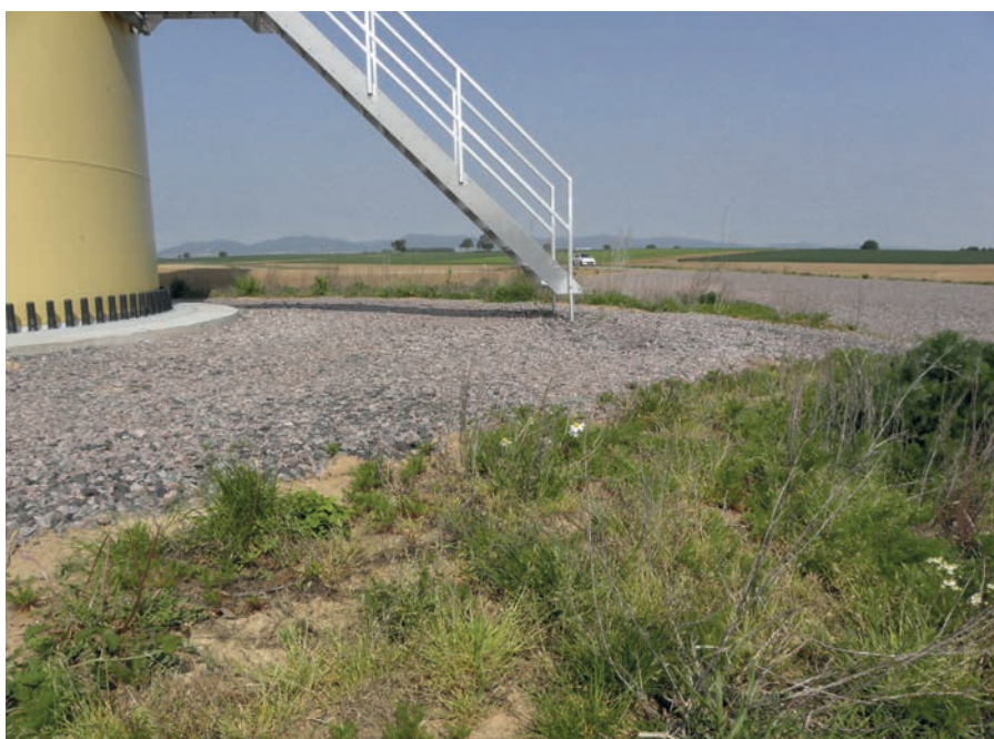
Abb. 12: Neue Anlage von 2018, im Mai 2019. Es gibt große Schotterflächen, die noch unbewachsen sind, aber keine Gebüschpflanzungen oder große Lößhügel. Mit der Zeit werden hier interessante Sonderhabitate entstehen, die für Ackergebiete untypisch sind und die Vielfalt an Strukturen im Gebiet erhöhen.
